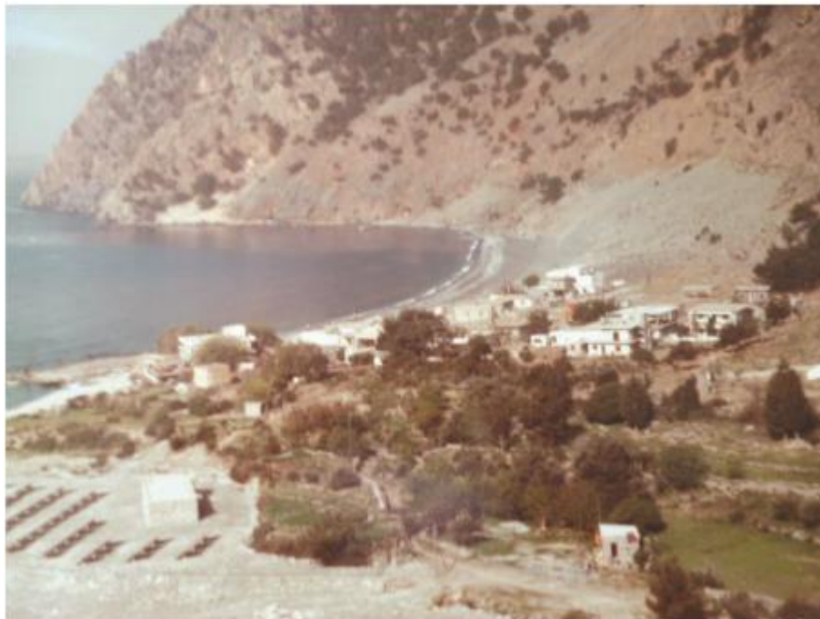
Figure A.1 Le village d'Aghia Roumeli, île de Crète, Grèce. Site de l'installation pilote PV, comme on peut le voir à gauche, à partir de 1983 à l'initiative de la Commission européenne.
