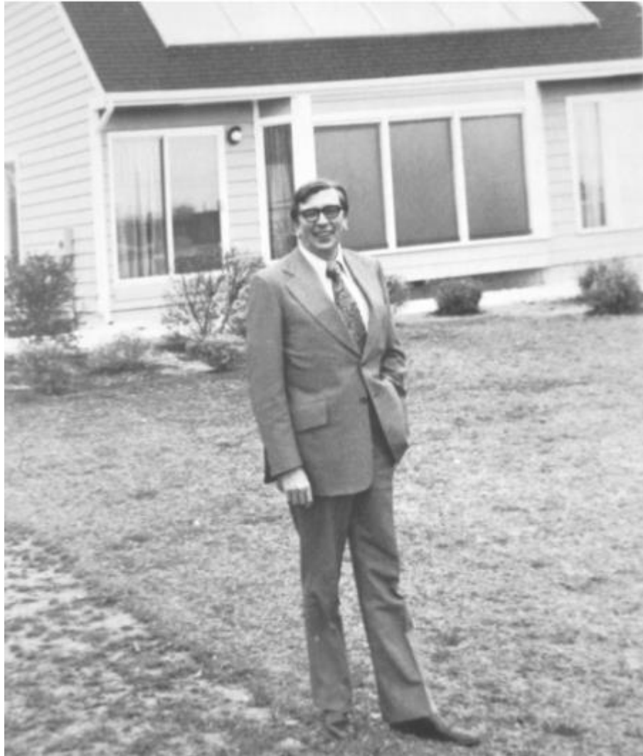
Figure 6.8 Karl Wolfgang Böer en 1973 devant son Solar One au Delaware, USA. C'était le premier bâtiment au monde avec un réseau PV intégré (photo de l'auteur).
